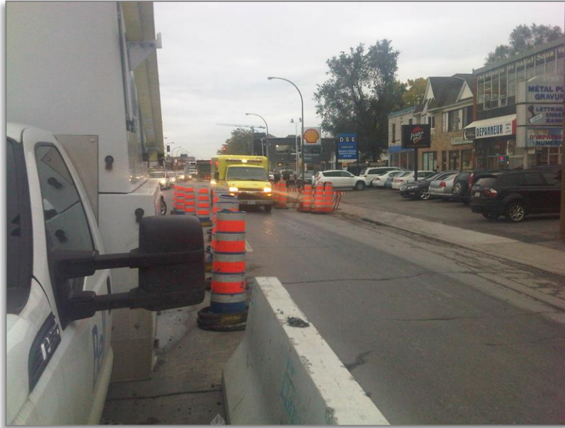
Figure 15 : Engagement d'un véhicule ambulancier à contre sens lors des travaux de remise en état sur la rue Jean Talon
